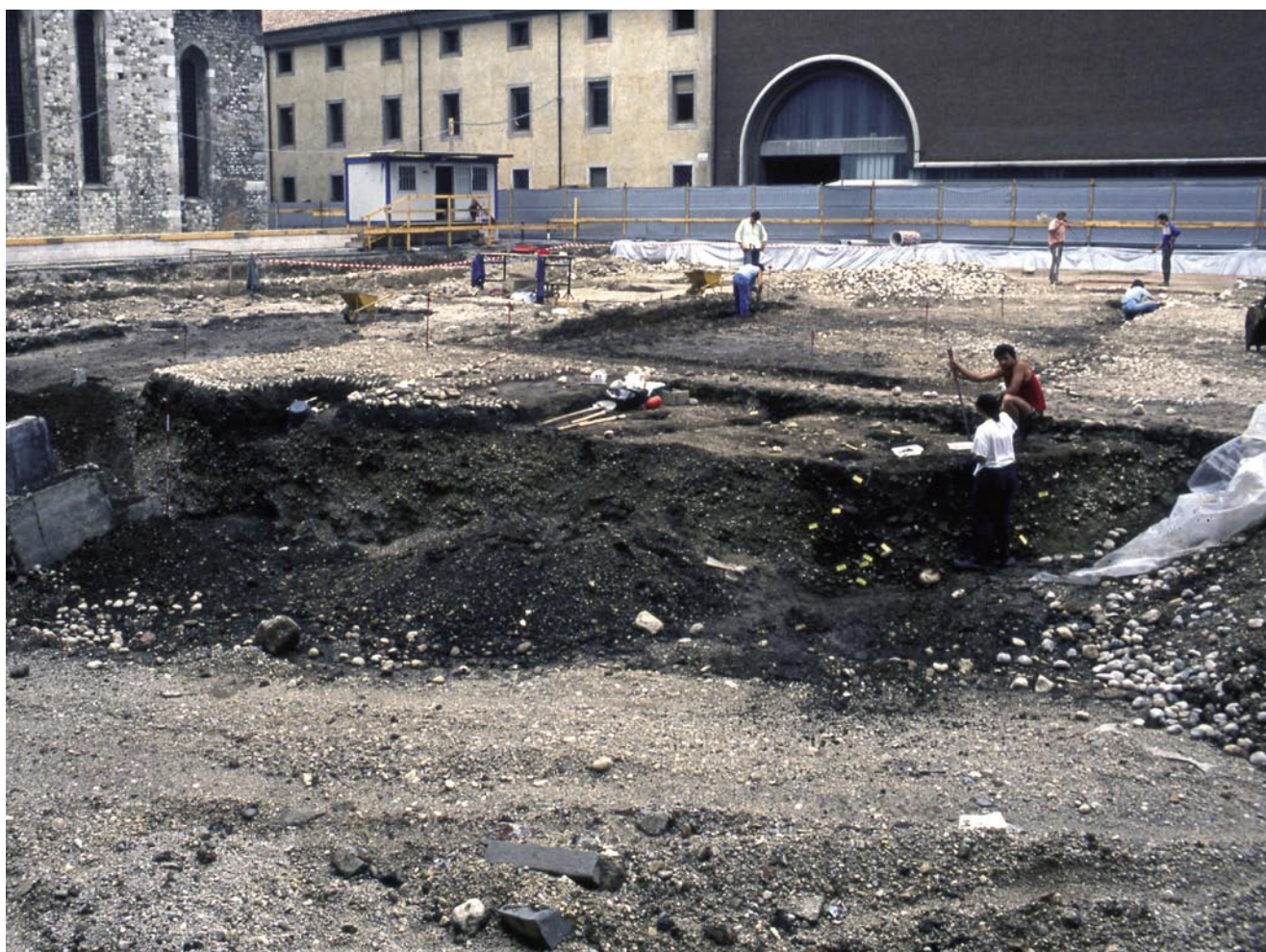
Fig. 3 - Attività di scavi nel sito di Piazza Venerio a Udine (fototeca dei Civici Musei di Udine). - Excavation in the site of Piazza Venerio in Udine (photo archive of the Civici Musei, Udine)
