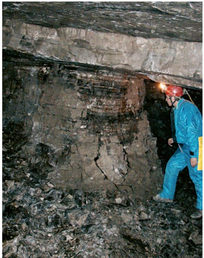
Fig. 25 - Un esempio dei cedimenti a carico dei pilastri.
