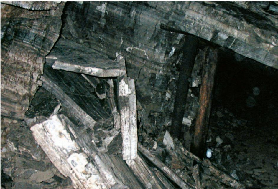
Fig. 28 - Nonostante la presenza di alcuni sostegni in legno, vi sono continui crolli in alcuni tratti della miniera.
