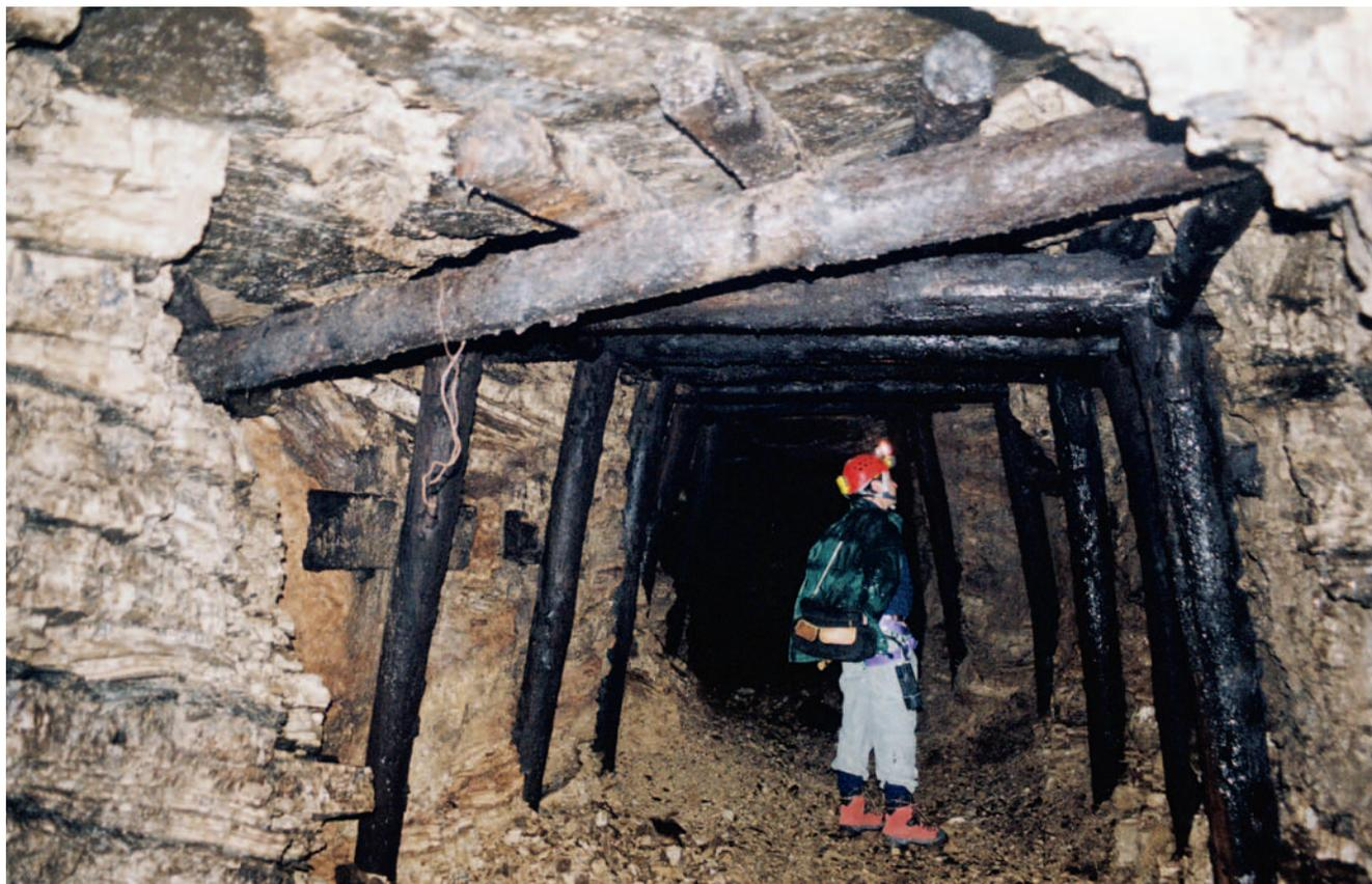
Fig. 26 - Galleria con travature: a sinistra si nota l'alternanza fra dolomie chiare e dolomie laminare scure.
