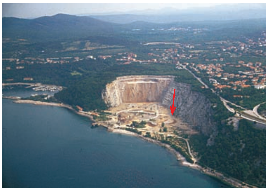
Fig. 1 - Il Carso e i punti acqua tenuti sotto osservazione dal DMG. Nel riquadro l'area sorgentifera del Timavo, in rosso la cava di Sistiana (da CUCCHI & ZINI, 2007). - Monitored water points by the DMG researchers. In the box Timavo springs area, in red the Sistiana quarry. (from CUCCHI & ZINI, 2007).
