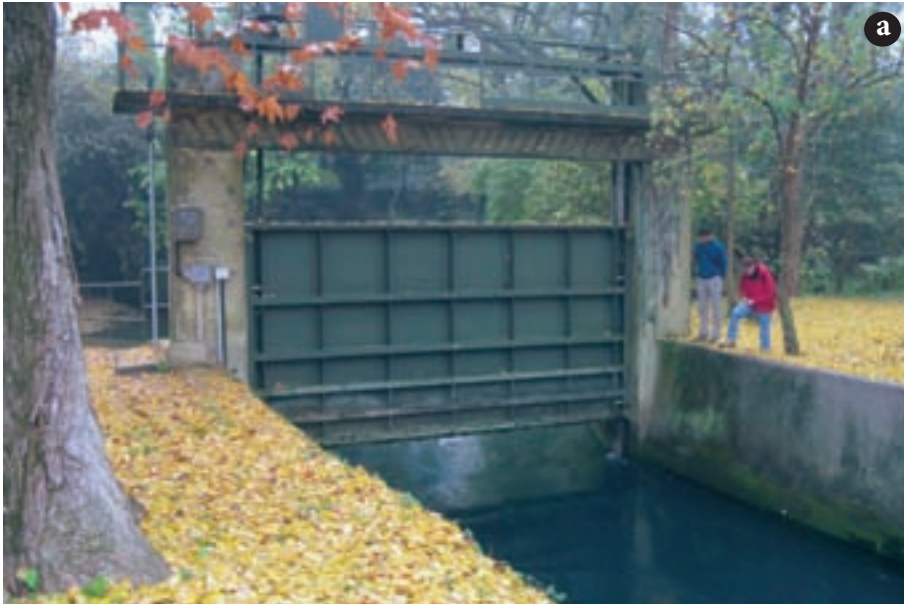
Fig. 3 - Sorgenti del Timavo: a) paratoia al 1° Ramo; b) stramazzo e paratoia al 2° Ramo; c) stazione di monitoraggio al 3° Ramo. - Timavo Springs: a) gate at the 1 st branch; b) weir and gate at the 2 nd branch; c) monitoring station at the 3 rd branch.
